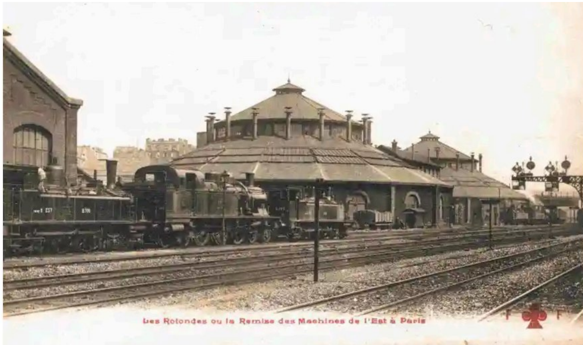
Les rotondes ou « remises annulaires » de La Villette vues vers 1910, pionnières du genre en France. Ce genre de rotonde, entièrement couvert, recevra parfois le surnom de « rotonde à chapeau ».
